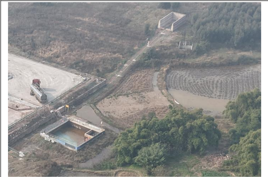
主体工程防治区-应急池、燃烧池周边土地整治现状
