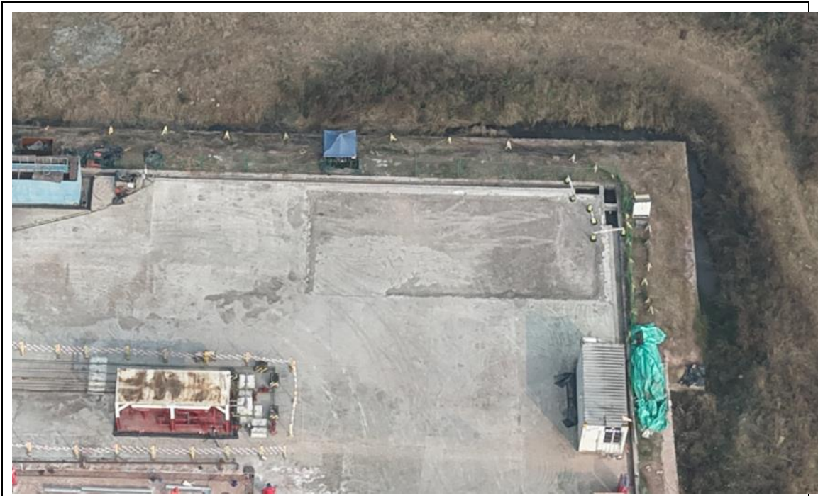
主体工程防治区-边坡撒播草种现状
