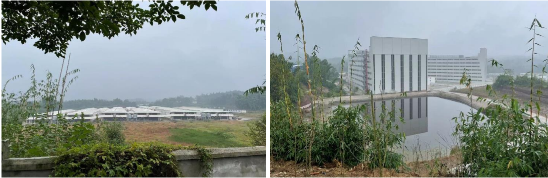
图 6-13 九峰山现状畜牧试验设施
